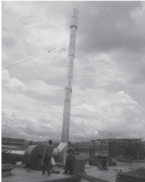
Foto. Desarrollo y prueba de equipos Purificadores de aire realizado en Alfages y Occidental de Colombia. Bogotá, 2002
