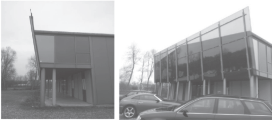
Figura 2. Nave industrial para emplazamiento del proyecto
